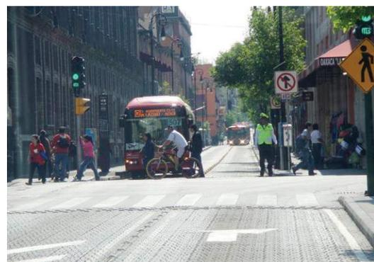
**Figura 47** Novos semáforos e sinalização horizontal indicando o final de uma faixa compartilhada e o início de uma faixa de ônibus exclusiva, onde o tráfego misto deve fazer conversão à direita
