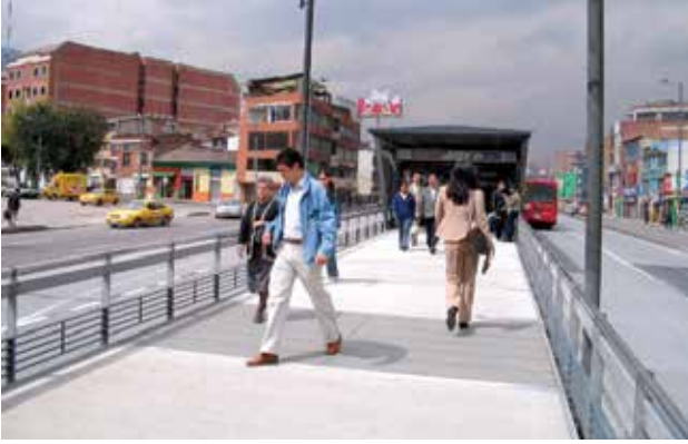
Şekil 54 TransMilenio 2006: Aynı istasyon içinde yer alan iki durak arasındaki yaya yolu. Yüksekliği yaklaşık 1 metre olan korkulukların alçak kaldığı dikkati çekmektedir. Bu korkuluklar çok alçak olduğu için insanlar bunların üzerinden kolaylıkla atlayabilir. Bu da yayaalar için büyük bir güvenlik riski oluşturmaktadır..
