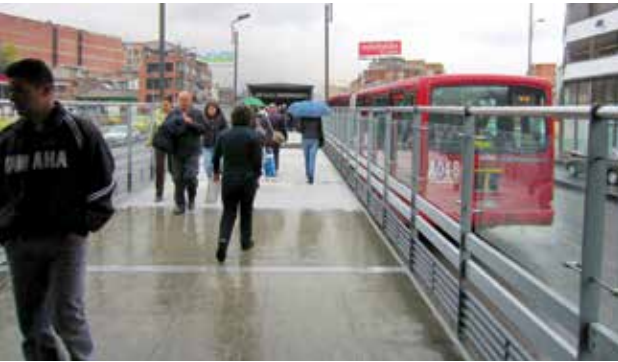
Şekil 55 TransMilenio 2011: yaya yolunun kenarındaki korkuluklar yükseltilerek üzerinden atlaması zorlaştırılmıştır. Aynı istasyon içindeki farklı tesisleri birbirine bağlayan yaya yollarında bu tür yüksek korkuluklar kullanılmasını önermekteyiz.
