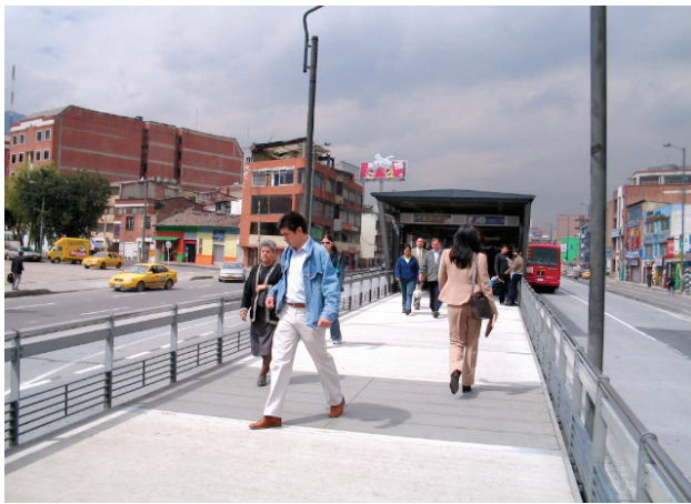
Hình 54 TransMilenio 2006: Một lối đi giữa hai điểm dừng tại cùng một bến xe. Chú ý đến các lan can thấp, cao khoảng 1 mét. Bởi vì chúng rất thấp, nên mọi người có thể nhảy qua chúng một cách dễ dàng, và điều này là một rủi ro lớn về an toàn cho người đi bộ.
