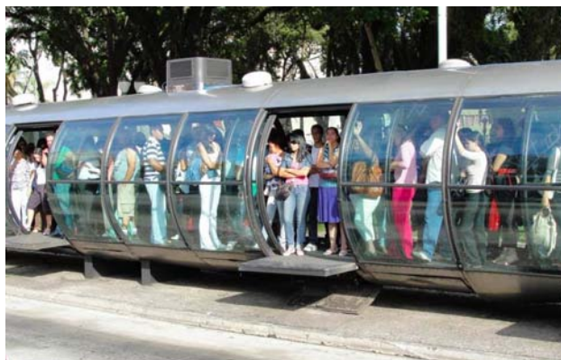
Hình 53 Cửa chắn tại một bến BRT ở Curitiba. Cửa được mở ra, ngay cả khi không có chiếc xe buýt nào xuất hiện. Đây là một rủi ro về an toàn tại một bến đông người, khi hành khách có thể ngã xuống làn đường xe buýt.
